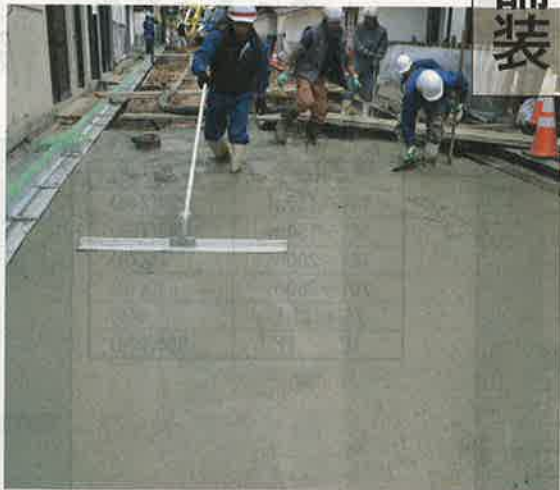
観光客らが多く通る小路で施工したワンデイペイブ。翌日には表層工の作業に入った
