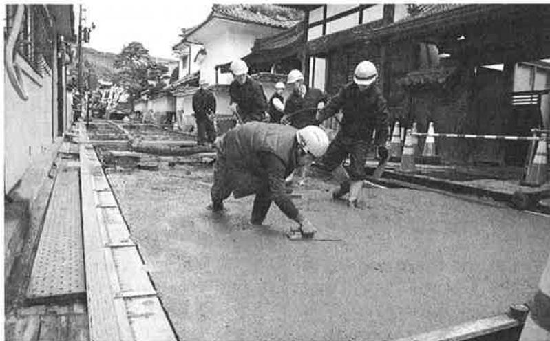
建設業の株式会社守谷商会は、現在長野市内で施工中の道路工事で、養生期間が1日で済む早期交通開放型コンクリート舗装技術「1DAYPAVE」(ワンデーペイブ)を導入し、11月26日に施工した=写真。
